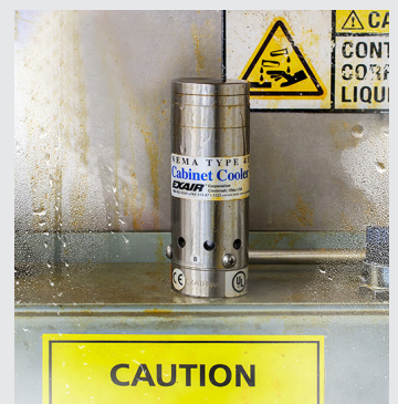
Kabinetkøler type 316 i rustfrit stål er velegnede til fødevarer, farmaceutiske samt til barske og ætsende miljøer, hvor 316SS foretrækkes.
